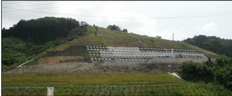
共用道路に“ばらまき型傾斜計”と“パケット通信機”を設置することにより、遠隔地にて法面を監視できます。
